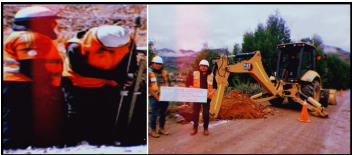
Figura 16. Ensayo de PDC in situ y extracción de muestra de suelo
