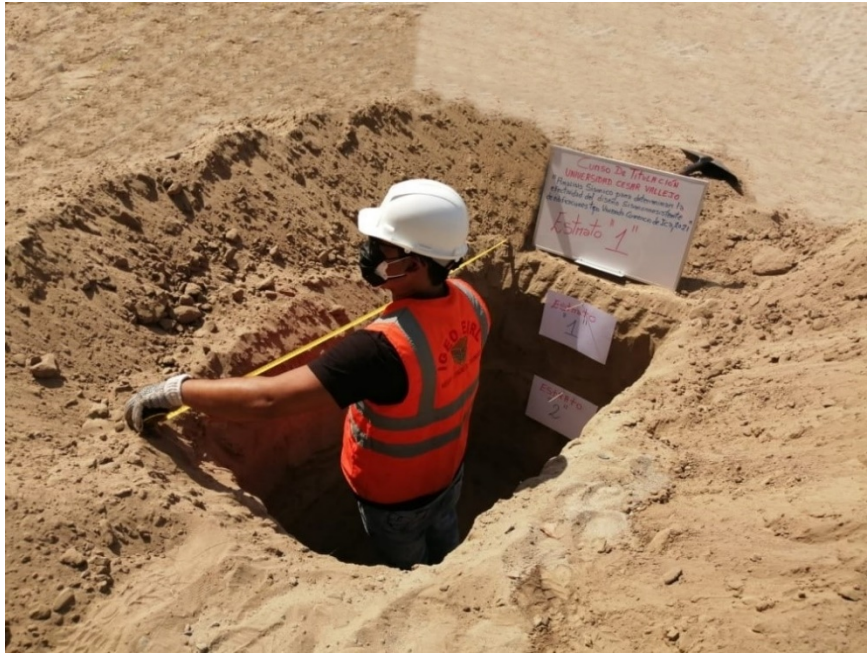
FOTO 5. MEDICIÓN DE CALICATA
