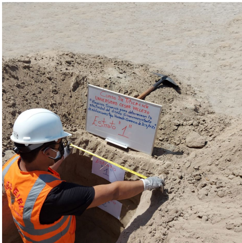
FOTO 6. MEDICIÓN DE CALICATA
