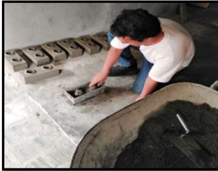
Figura 10. Compactación de la mezcla en el molde.
