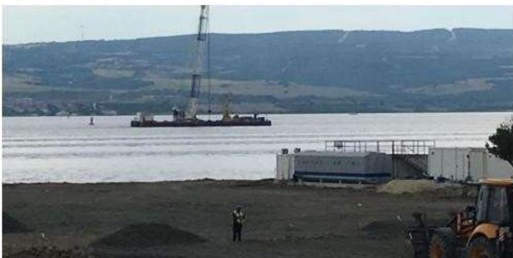
Figura 5: Pilotes hincados Fuente: Kusku, (2018)
