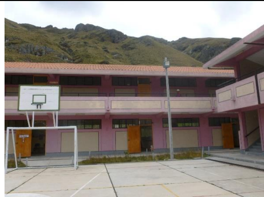
Figura. Vista frontal del pabellón a estudiar
