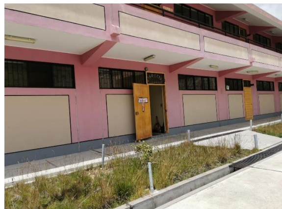
Figura. Vista del primer piso del pabellón
