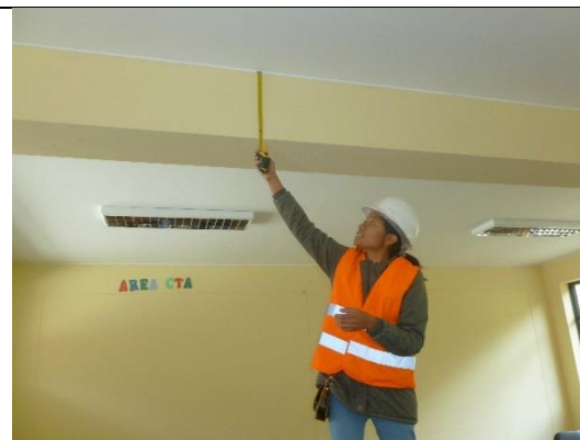
Figura. Mediciones de elementos estructurales
