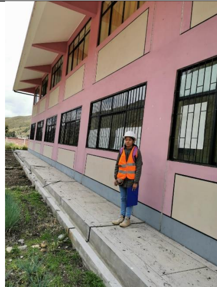
Figura. Inspección en la vista posterior del pabellón
