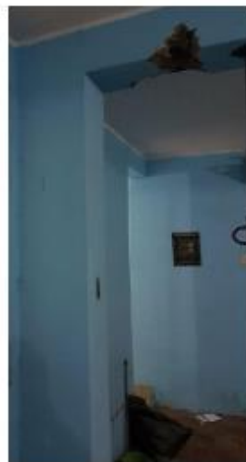
Viga V-4 del aula del segundo piso
