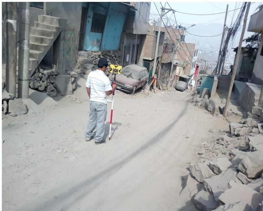
**ANEXO 16.** Levantamiento Topográfico, Ilegando a la distancia proyectada para el diseño del Sistema de alcantarillado
