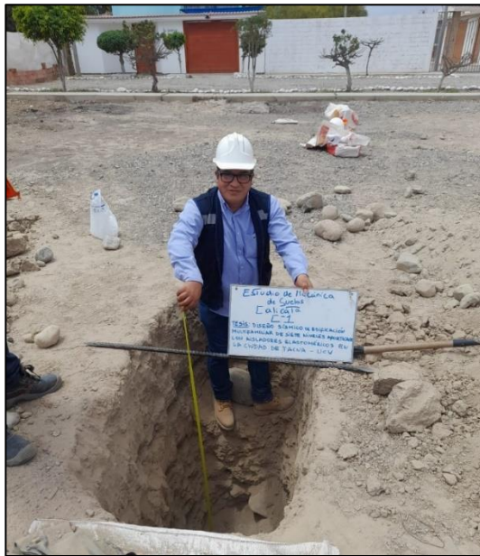
Figura 15. Excavación de calicata
