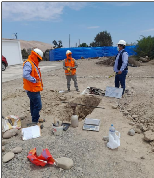
Figura 16. Excavación de calicata
