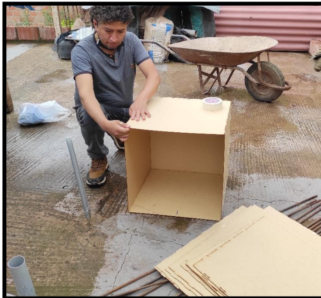
FOTOGRAFIA 1: Armado de moldes para encofrado de placas en forma de cubo
