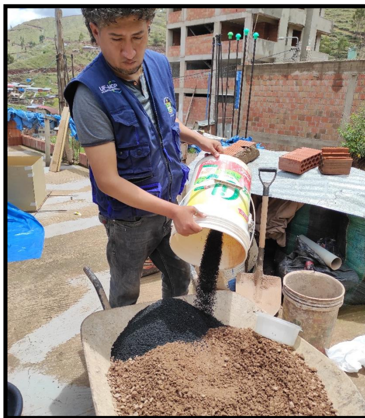
FOTOGRAFIA 2: adición y medida de materiales según dosificación.
