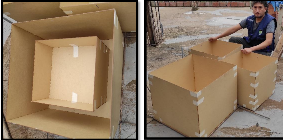
Figura 21. Moldes de distintos espesores para encofrado de placas de concreto en forma de caja.
