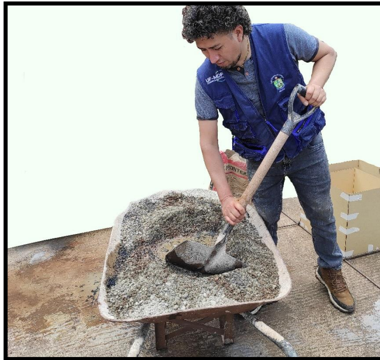
FOTOGRAFIA 3: mezcla de materiales según dosificación
