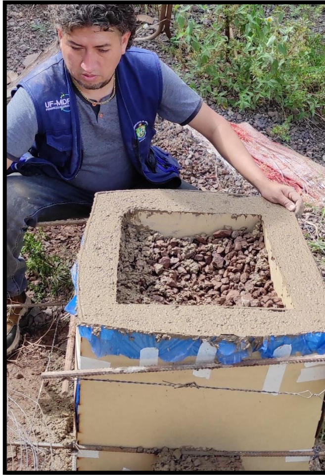
FOTOGRAFIA 5: moldes de placas en forma vaciados.
