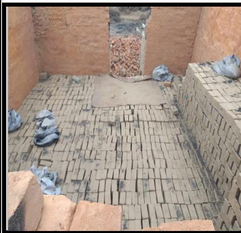
Visita a la ladrillera Canales - Ica.
