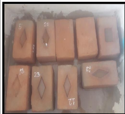
Se humedeció los ladrillos para que no le quite agua al mortero.
