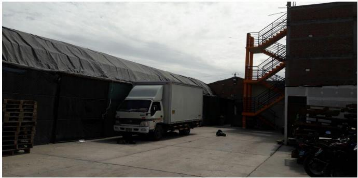
Figura 9. Patio de camiones y despacho de mercadería
