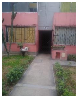
Foto 1: Vista de Fachada de ingreso al departamento Fuente: Propia
