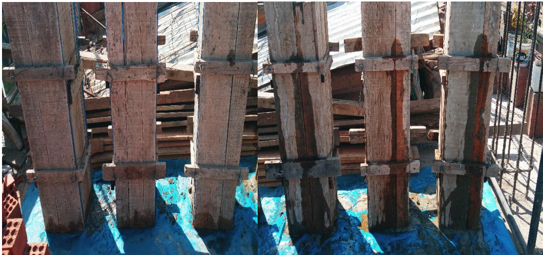
Figura 29. Vaciado de 6 columnas experimentales.
