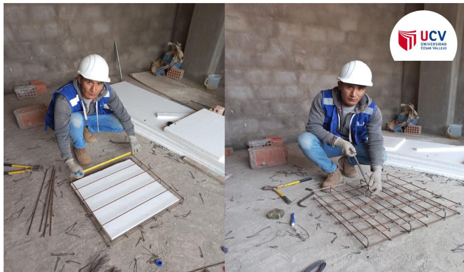
Figura 19. Elaboración de malla y corte de poliestireno
