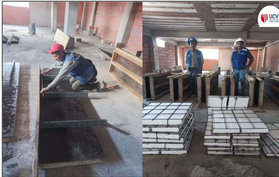
Figura 18. Encofrado de muros ultra ligeros
