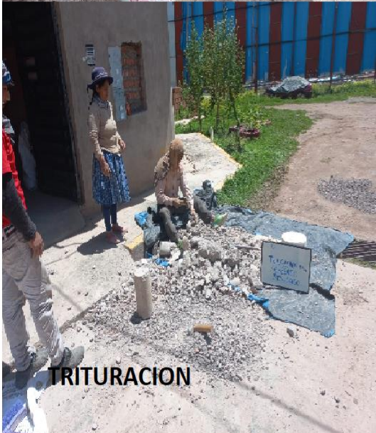
ACOPIO DE AGREGADO RECICLADO
