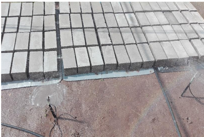
Figura 8: Curado de bloques con microjet
