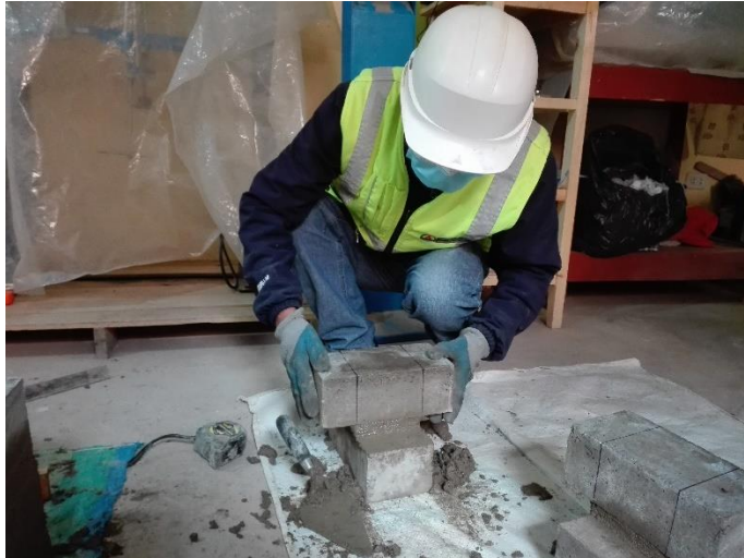
Figura 10: Construcción de bloques cruzados de concreto
