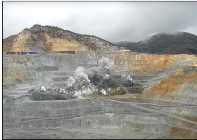
Figura 4. Voladura en mina
