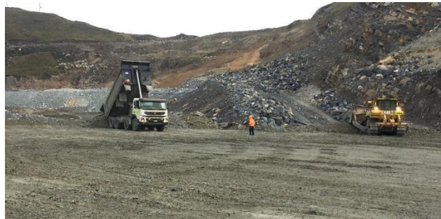
Figura 7. Descarga en mina
