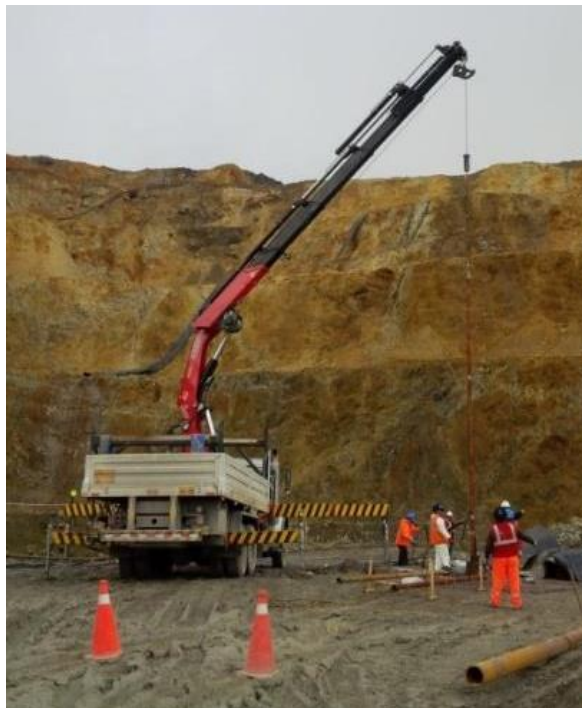
Figura 3. Perforación de mina
