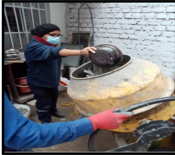
Figura 16. Mezcla de los materiales
