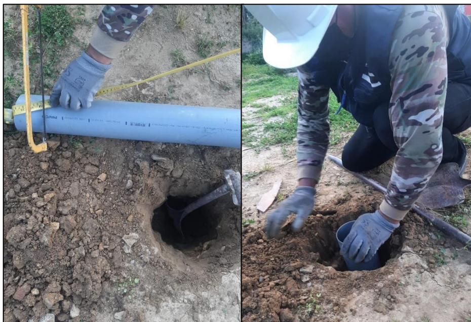
Figura 25: Colocado del tubo en el hoyo
