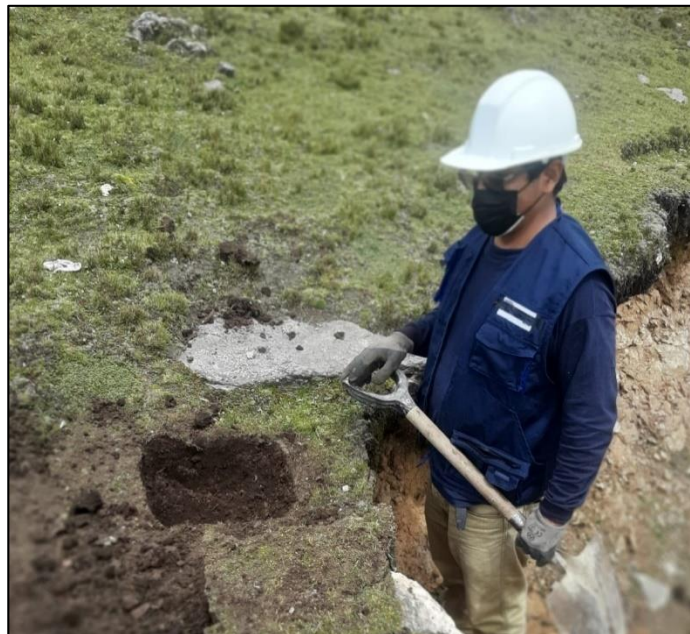
Figura 18: Excavación de calicatas
