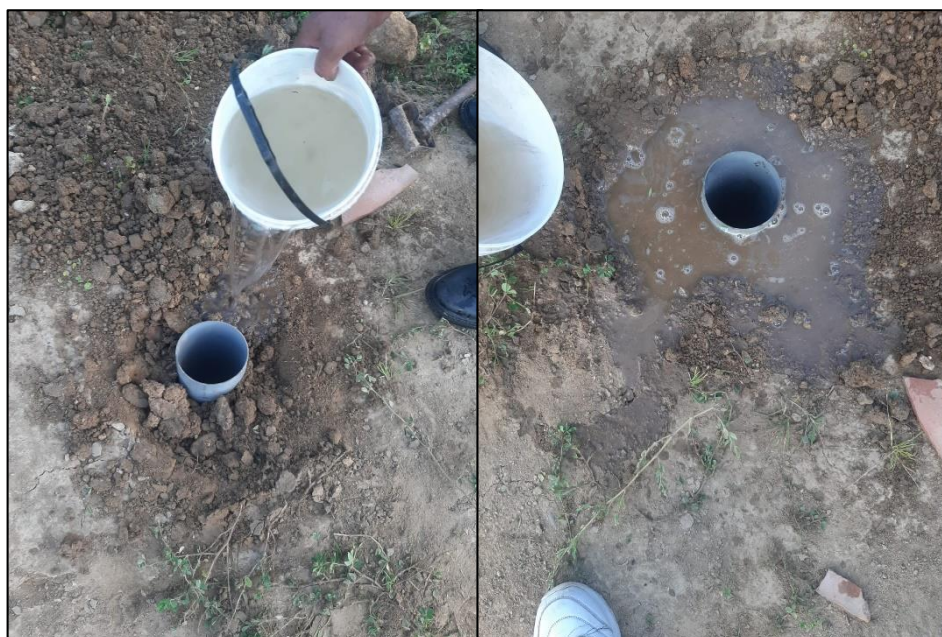
Figura 26: Llenado de agua alrededor del tubo en el hoyo
