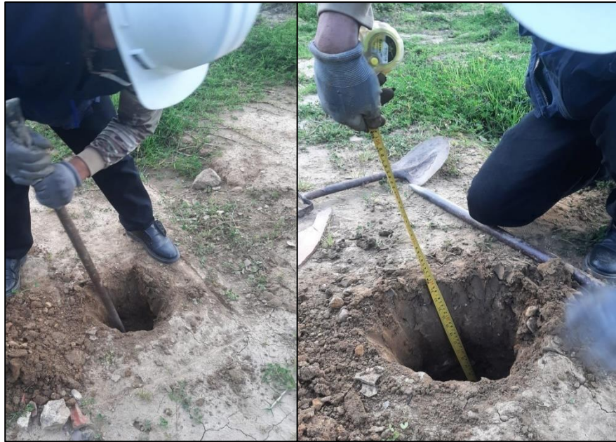
Figura 24: Excavación del hoyo
