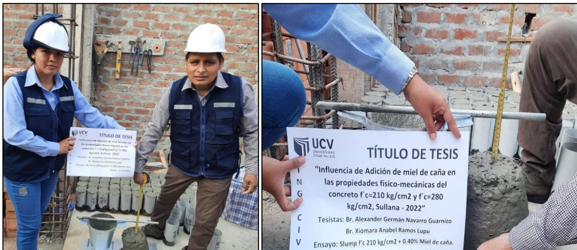
Figura 25: Ensayo para verificar el asentamiento.
