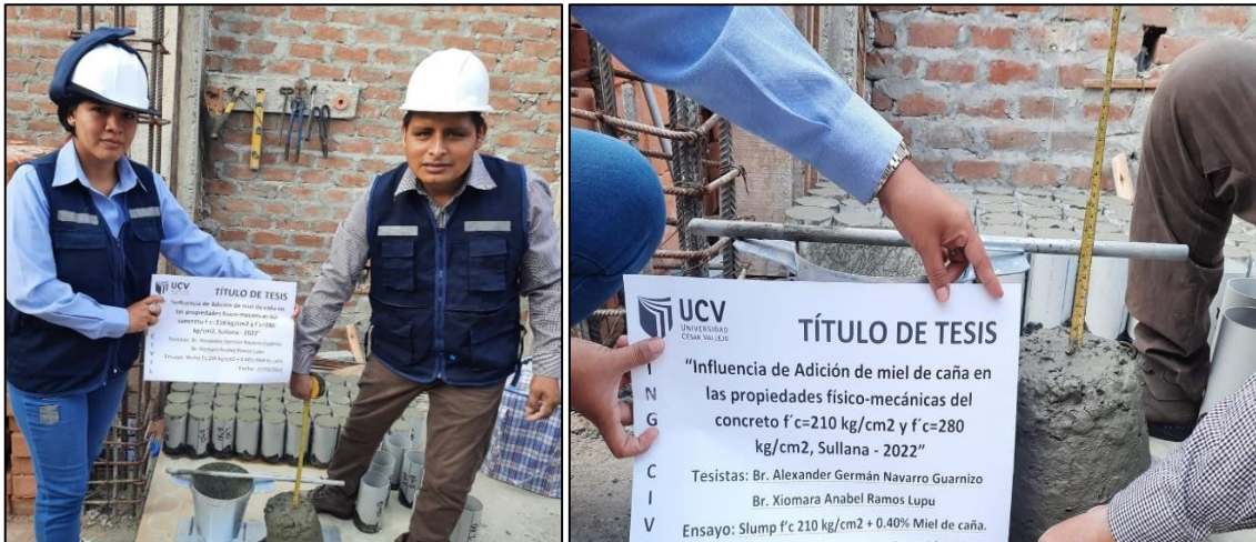
Evidencia N°04: Ejecución de ensayo para verificar el asentamiento (SLUMP).
