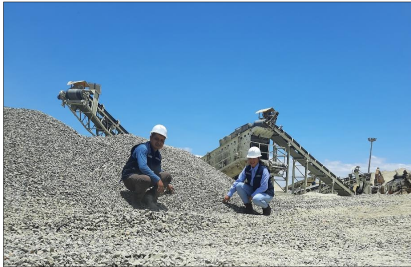
Figura 12: Obtención del agregado grueso y del agregado fino (procedente de la cantera de Sojo y Santa Cruz).
