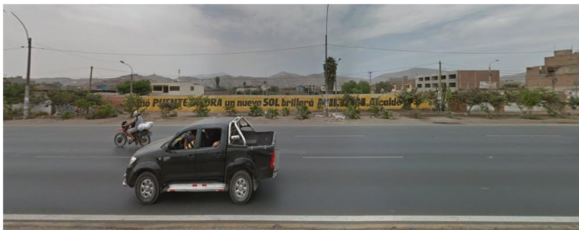
Figura 30. Fachada frontal del terreno cercada de muros, vista desde la Av. Panamericana Norte
