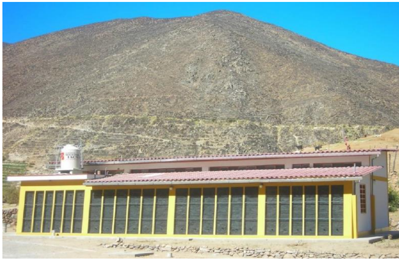
Figura 11: Muro de inercia en posta médica en Toquepala. Pared pintada de negro mate. Fuente. Rivasplata, X. (2018).
