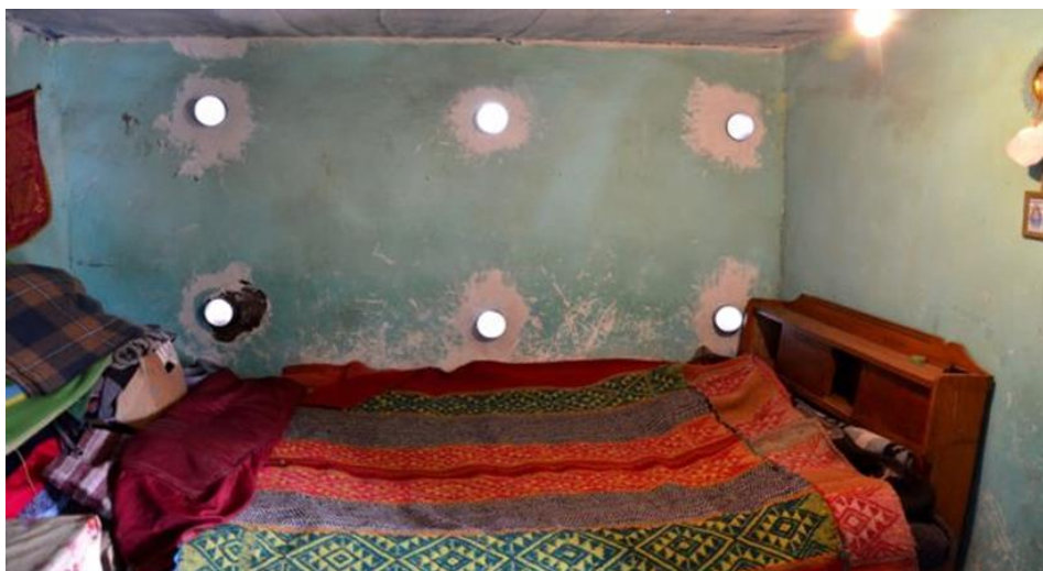
Figura 23: Muro Trombe de una casita caliente Fuente: El comercio.pe. (21 de octubre de 2016).
