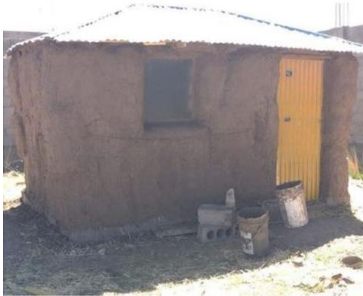
Figura 5: Modelo de vivienda construida con pacas de avena. Fuente: Suasaca Pelinco, Leonel et al. (2020).
