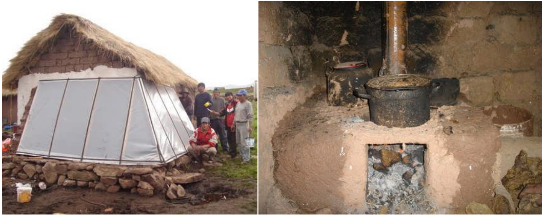
Figura 24. Exterior del muro Trombe (izquierda) y mejorado de fogón Fuente: (Grupo PUCP, 2009).
