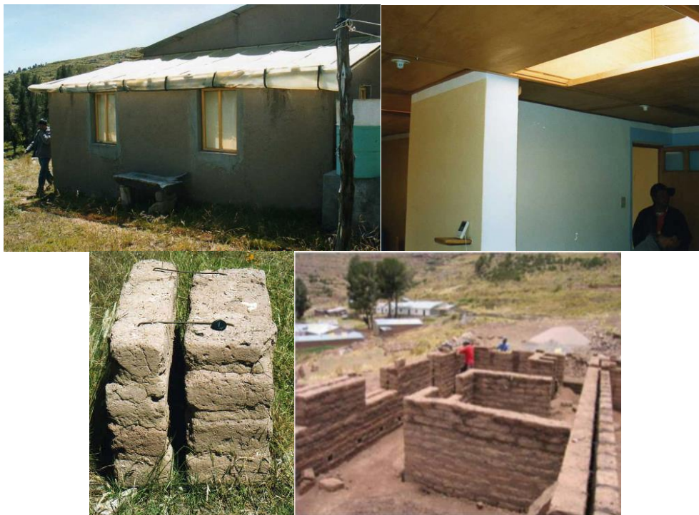
Figura 30: casa caliente con invernadero adosado, claraboyas y aislamiento de las paredes. Fuente: Huaylla (2010) y Flores (2017).
