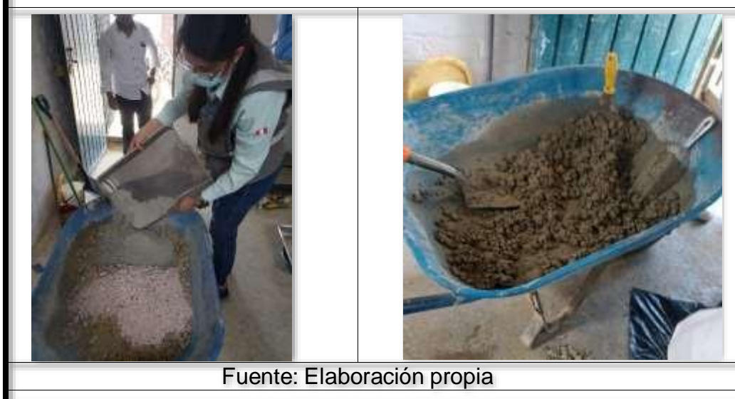
Figura 32: Mezcla de agregados
