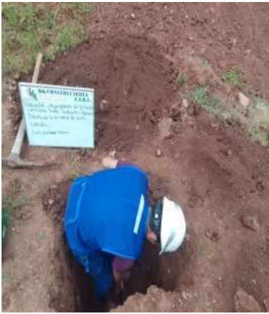
Fotografia N°1: Excabacion de la calicata en el sector Teleloyoc huaycco.
