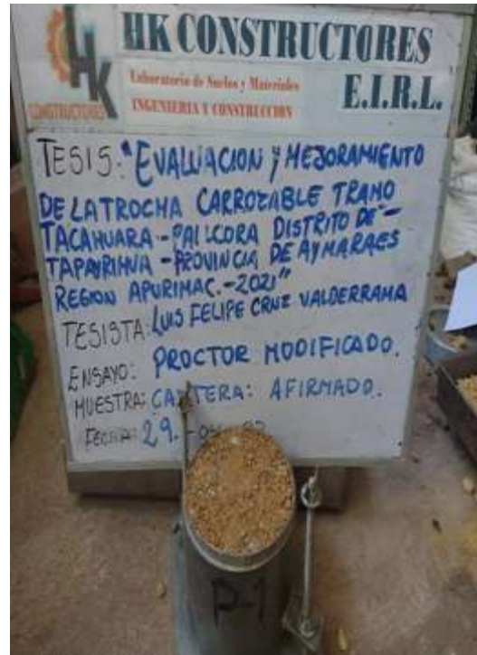
Fotografia N°5: compactacion para proctor modificado
