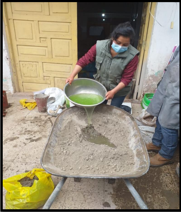
Grafico 29 : adición de agua colla a la mezcla del concreto
