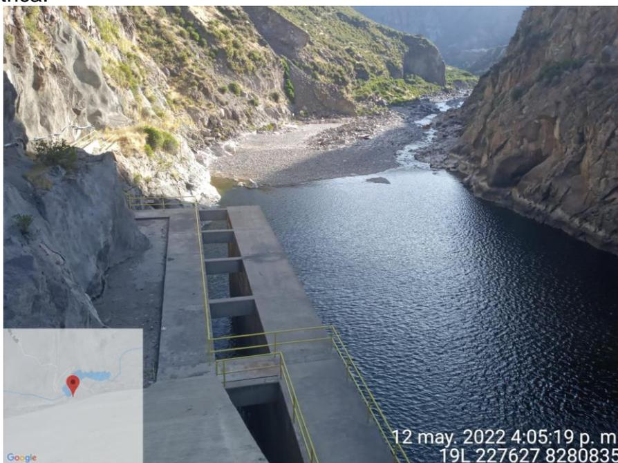
**Imagen N°03.-** Tunel de derivación de agua e infraestructura hidráulica para la derivación del agua hacia el canal de aducción del sistema regulado Colcasiguas de la bocatoma de Tuti.
