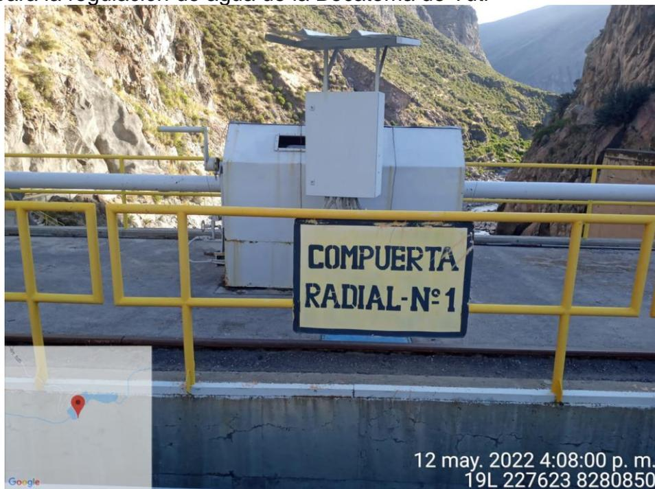
**Imagen N°04.**-Uno de los tres sistemas electromecánico que registra el caudal aguas abajo de la bocatoma de Tuti.
