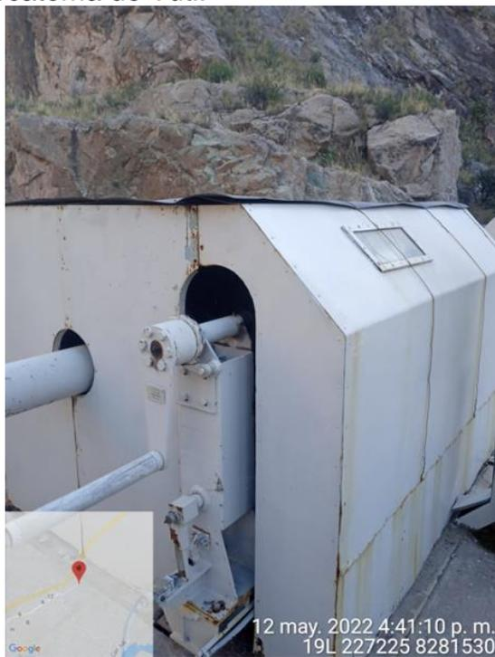
**Imagen N°05.-**Panel de control que permite la regulación manual de una de las compuertas de aducción del canal majes y es partes del sistema de registro información de caudal derivado hacia el canal de aducción.
