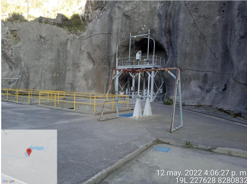
**Imagen N°04.-** Una de las tres Compuertas radiales de la bocatoma de Tuti que sirve para la regulación de agua de la Bocatoma de Tuti
