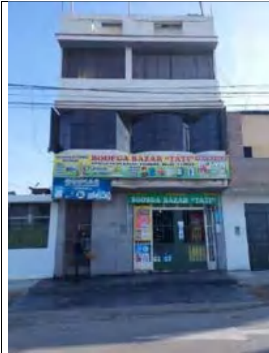
Foto 1: Fachada de Edificación 1.
