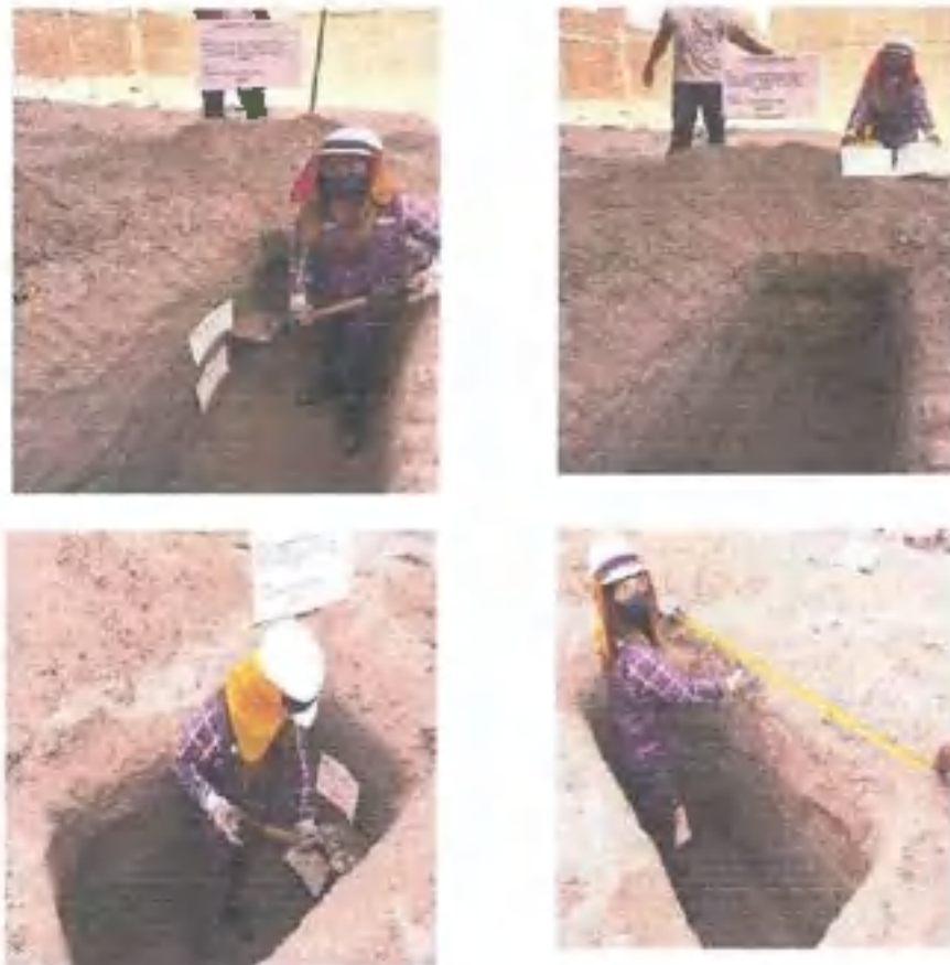
Figura 5.1.1 - Detalle de calicatas.
