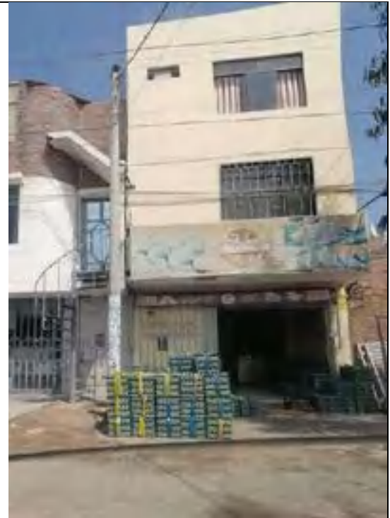
Foto 2: Fachada de Edificación 2.
