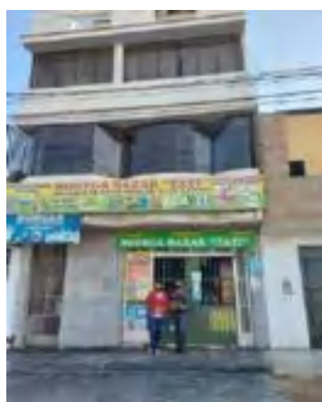
Figura 9. Fachada de la primera edificación.
