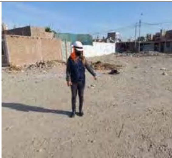
Foto 3: Ubicación de calicata para Edificación 1.
