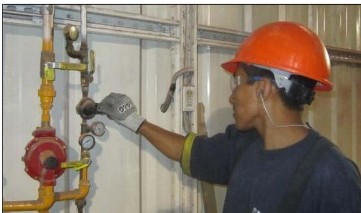
Ilustración 5. Se abre la llave reguladora de gas
