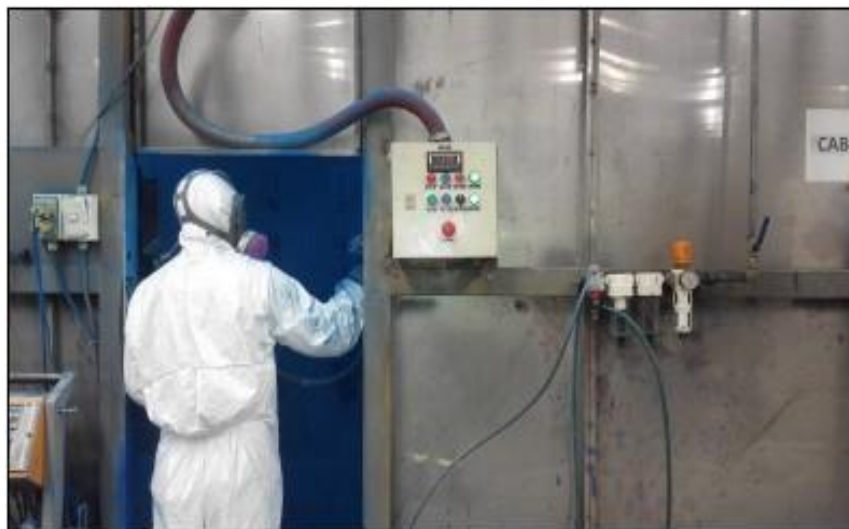
Ilustración 8. Puesta en marcha cabina de pintura
