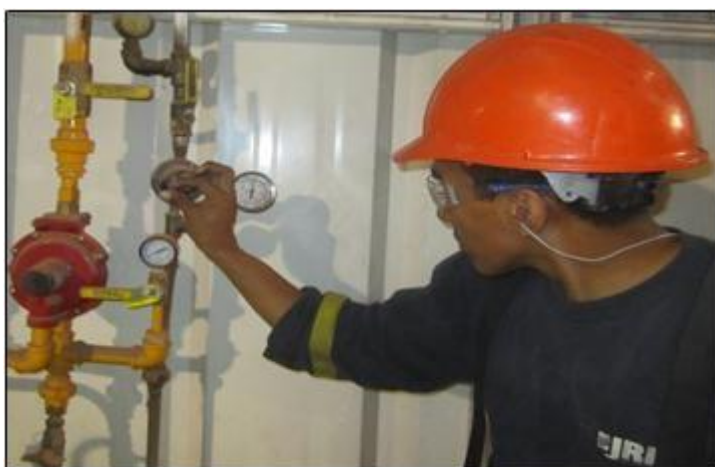
Ilustración 6. Regulación de la válvula % de gas
