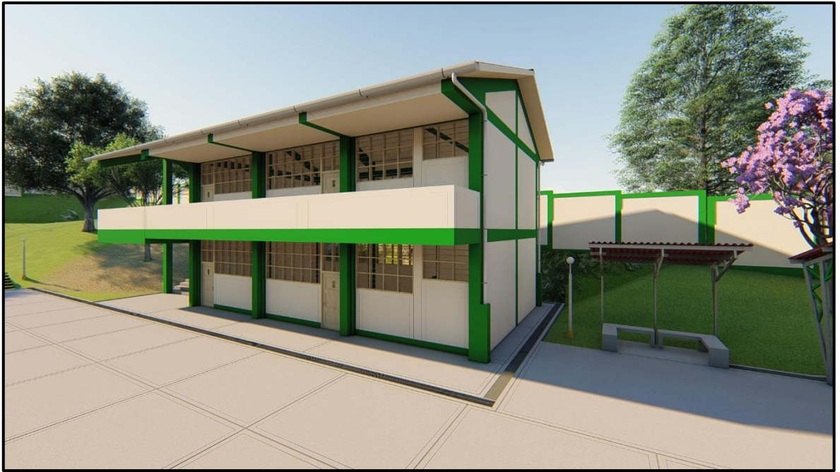
FIGURA 23: Se observa la edificación 09 (biblioteca y AIP I )
