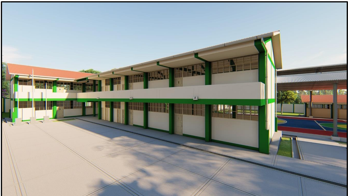
FIGURA 24: Se observa la edificación 11 (Aulas y SS.HH )
