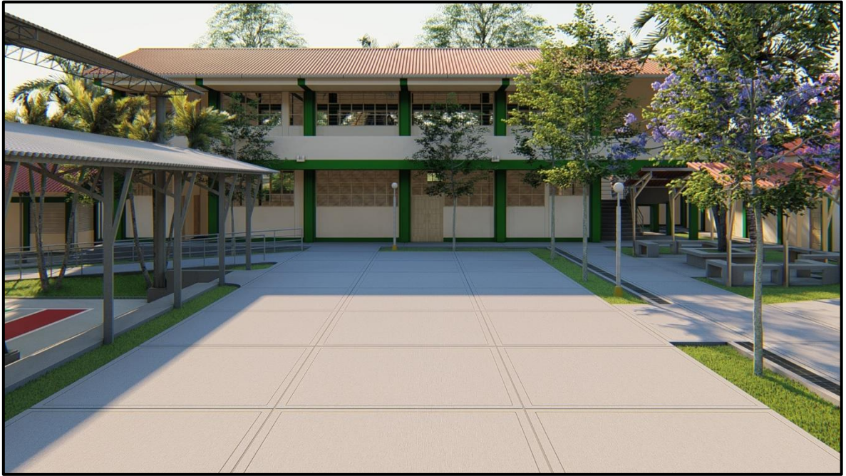
FIGURA 21: Se observa la edificación 05 (administración y sala de unos multiples)
