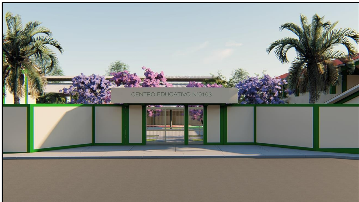
FIGURA 18: Se observa el ingreso principal al cetro educativo N°0103
