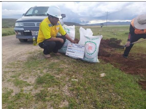
Fotografía 5. Excavación de calicatas
