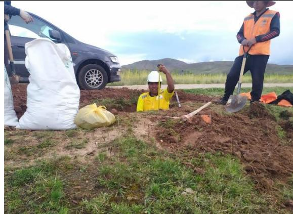
Fotografía 4. Medición de la profundidad de excavación
