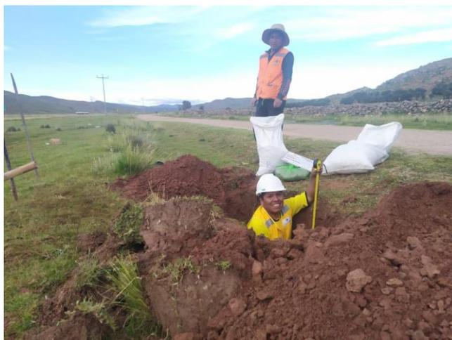
*Figura 4.* Excavación de las calicatas
