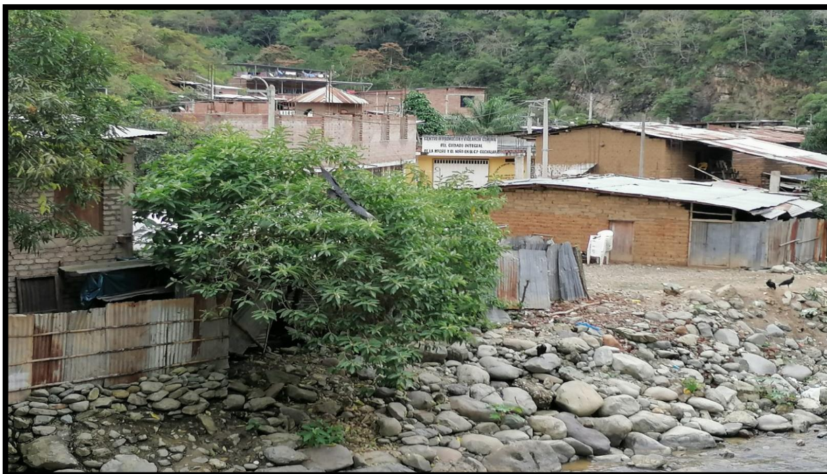
Figura 9: Margen derecha de la quebrada Cochalan agua abajo del puente.
