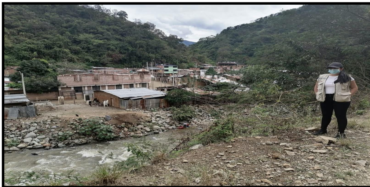
Figura 11: Margen derecha de la quebrada Cochalan agua abajo del puente.
