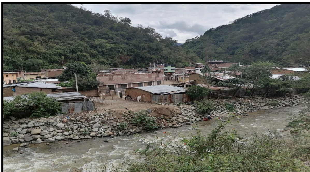
Figura 10: Margen derecha de la quebrada Cochalan agua abajo del puente.
