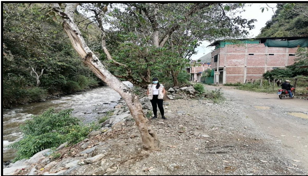
Figura 13: Imagen de la margen izquierda de la quebrada Cochalan aguas arriba del puente.
