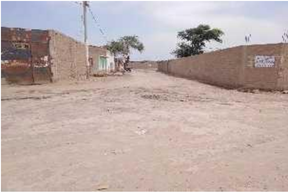
Foto 3. Zona no pavimentada
