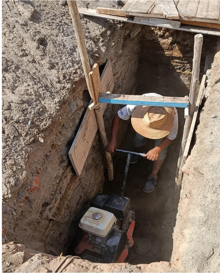
Figura 62. Compactación de la primera capa de Suelo-Cemento.
