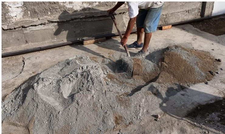
Figura 60. Combinación de Suelo-Cemento.
