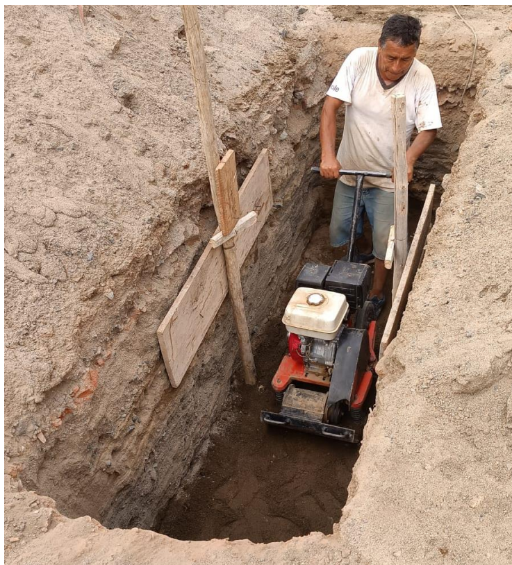
Figura 91. Compactación de la última capa.
