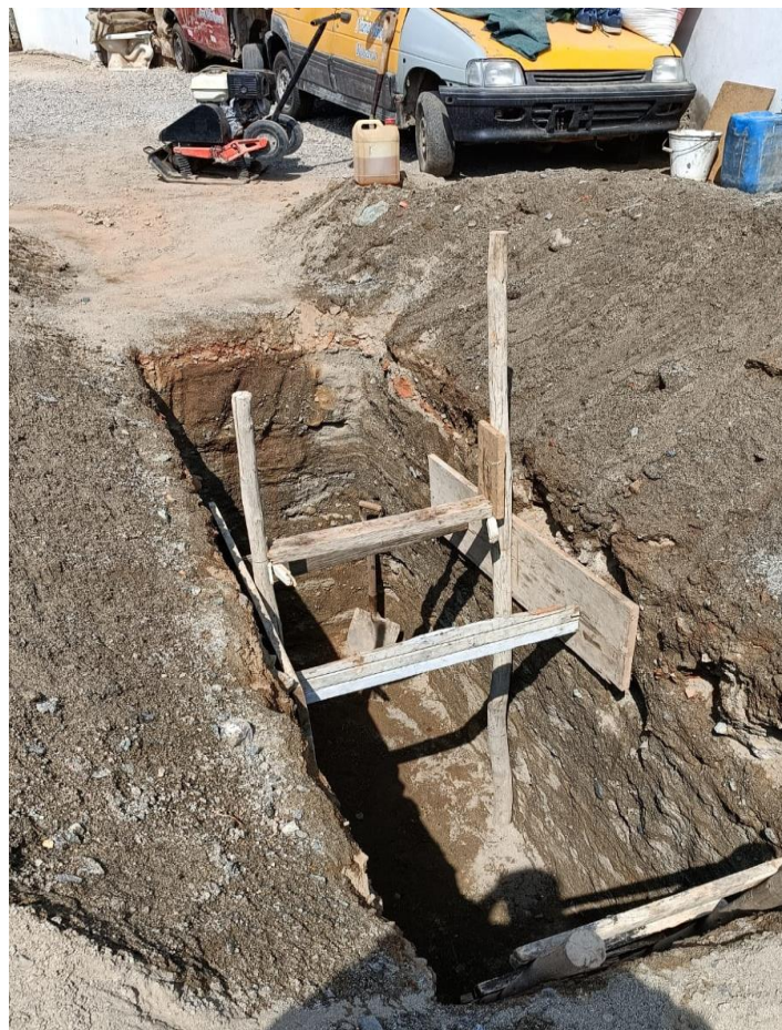
Figura 90. Preparación de la Superficie para el Espesor de Mejoramiento.
