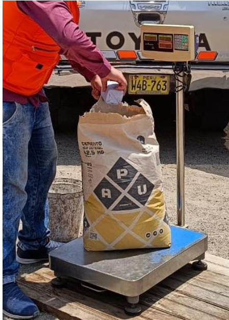
Figura 59. Control de la Proporción de Cemento en Peso.
