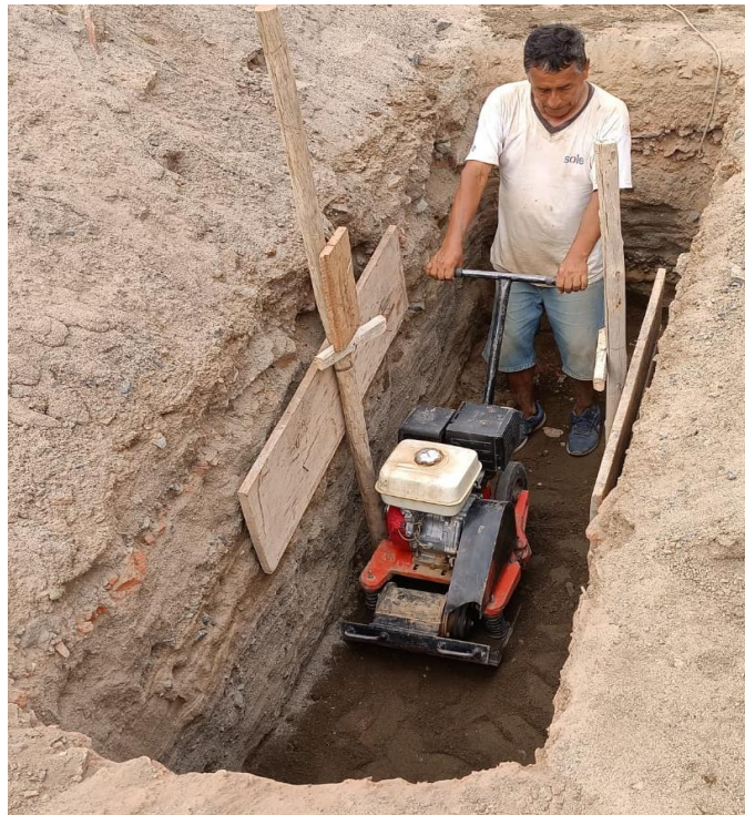
Figura 63. Compactación de la última capa de Suelo-Cemento.
