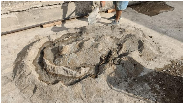
Figura 61. Humedecimiento de la combinación Suelo-Cemento.
