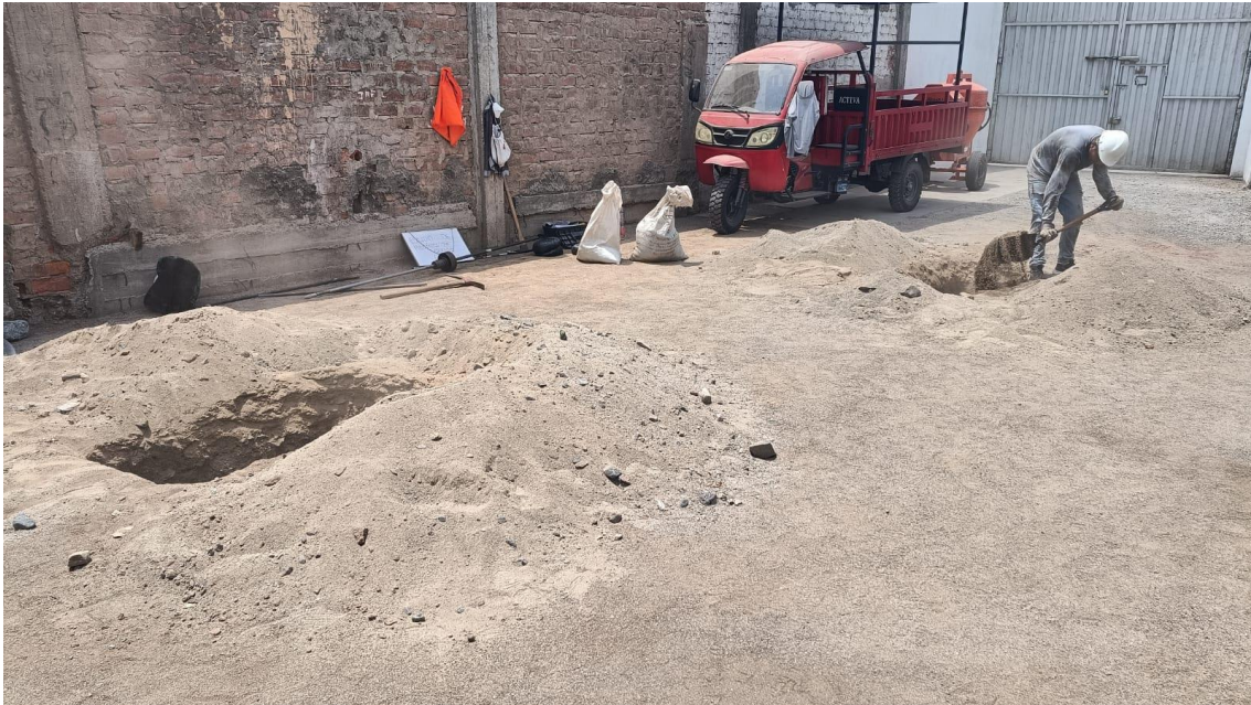
Figura 85. Vista General de las Calicatas.
