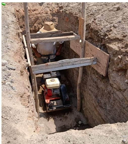
Figura 58. Compactación en el Fondo de Excavación.
