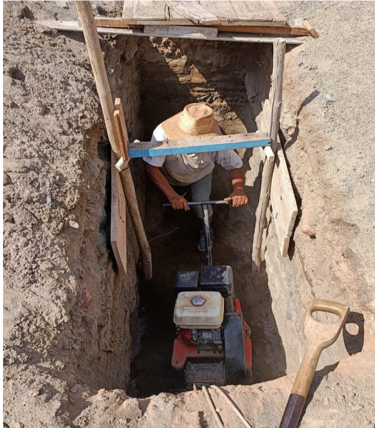
Figura 90. Compactación de las Capas de Mejoramiento.
