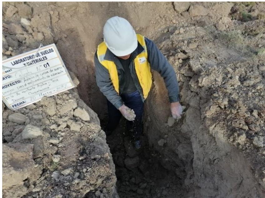
Fotografía 3: Extracción de calicatas
