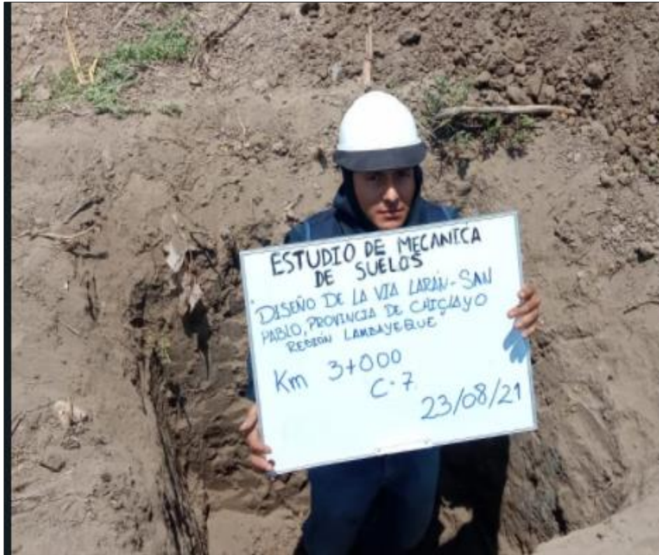
Figura 17. Exploración de la calicata N° 07 para extracción de la muestra.
