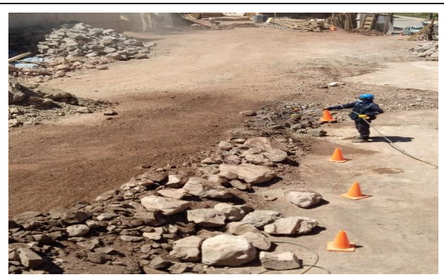
Figura 8. Riego del terreno de obra para mitigar la generación de material particulado
