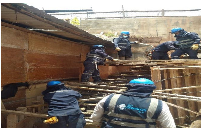
Figura 17. Adecuado uso de EPP's en los trabajos de encofrado y vaciado de concreto para la construcción de escaleras del proyecto.
