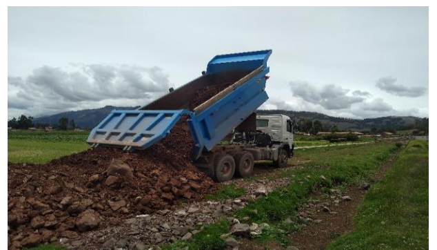
Figura 10. Se verifico la adecuada disposición de desmontes en áreas autorizadas, en las cuales serán reutilizadas como relleno de áreas erosionadas, mitigando el impacto ambiental.
