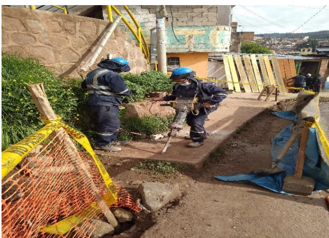
Figura 19. Uso de EPP's de protección auditiva y visual durante los trabajos de rotura de pavimentos.
