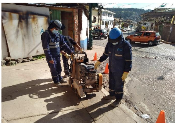
Figura 15. Mitigación en la generación de material particulado producto de corte de pavimento.
