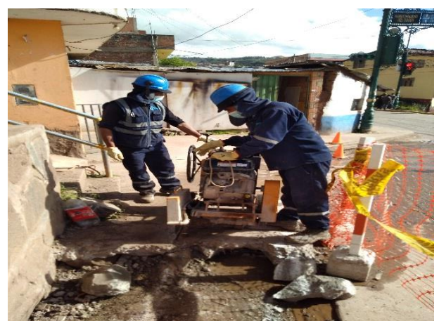
Figura 20. Uso de EPP'S para mitigar el material particulado y ruidos durante el corte de pavimentos.
