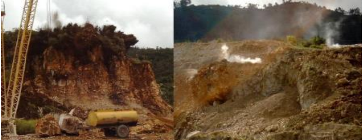
Figura 7. Explotación de cantera tembladera
