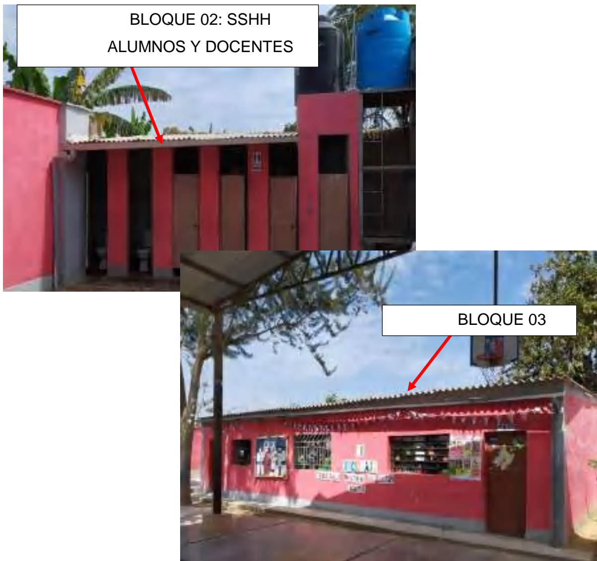
Figura 2. Se muestra el bloque 02 y 03 formado por aulas construidos a base de material rustico-adobe que tiene la institución educativa.
