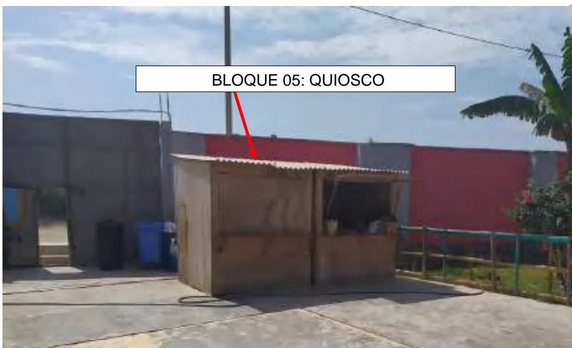
Figura 3. Se muestra el bloque 05 formado por ambiente construidos a base de triplay que tiene la institución educativa.
