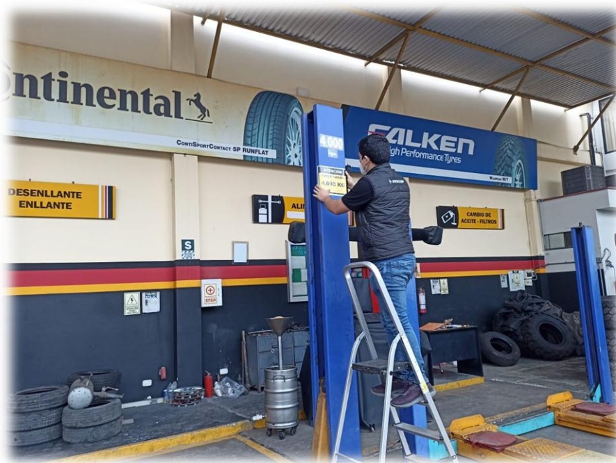
Anexo 24.8: Pegado de señalización 8
