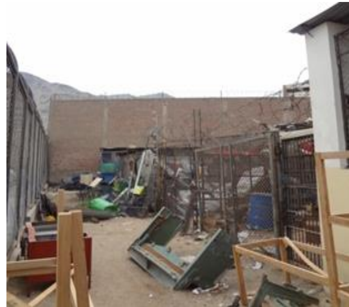
Área de talleres que colapsan por la aglomeración de insumos de los internos para la fabricación de sus productos. Las áreas de talleres claramente no contribuyen en la rehabilitación penitenciaria.
