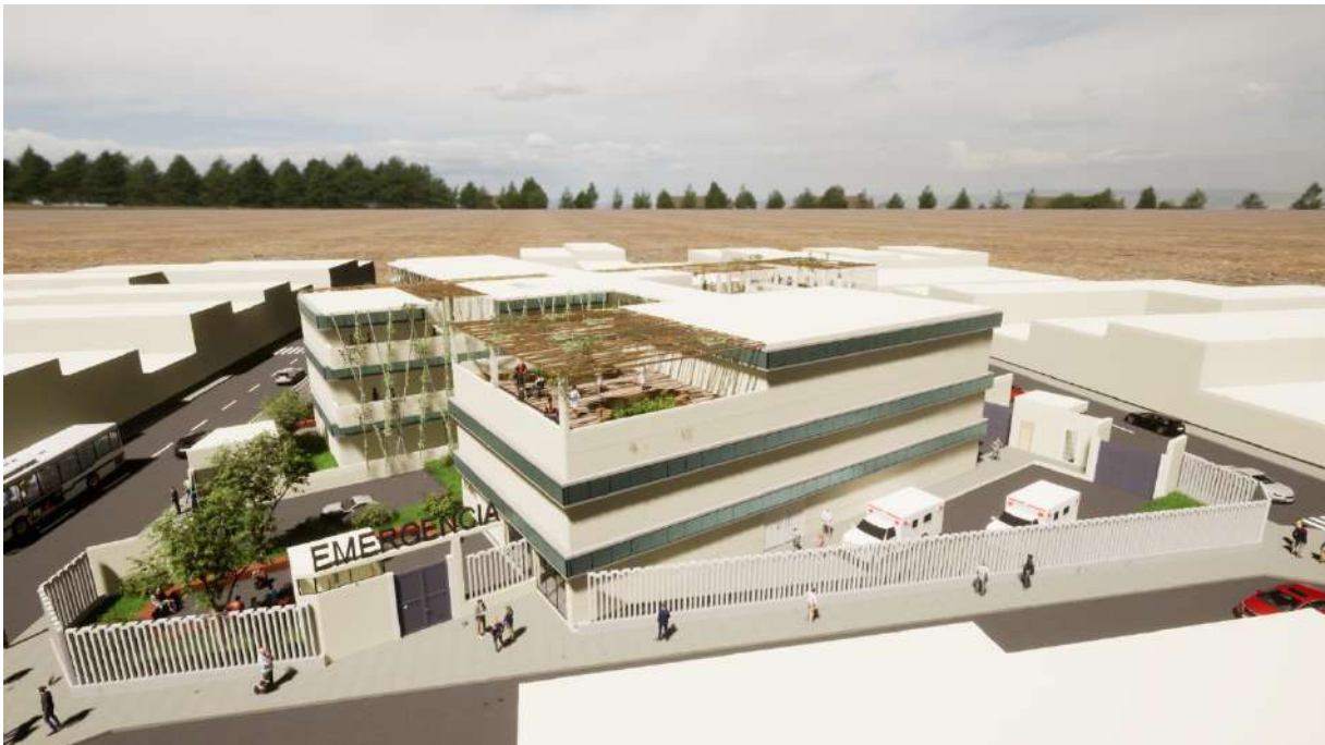
Figura 111: Vista desde el sector de Emergencia
