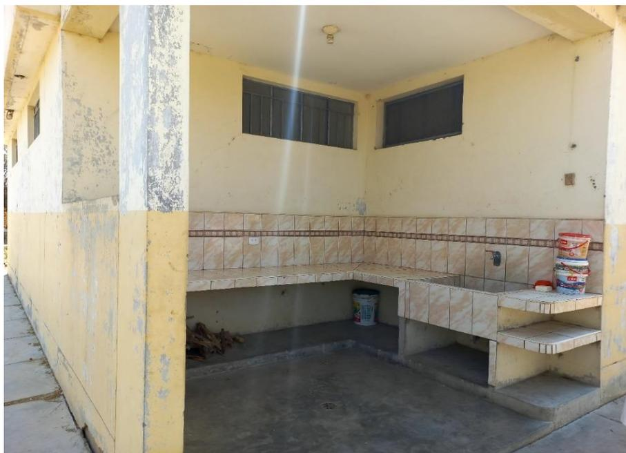
En la imagen se puede apreciar que el espacio se encuentra en mal estado, su pintura se está deteriorando debido a las fuertes lluvias. Además, ante la carencia de espacio este lugar dejó de funcionar como lavandería, esta actividad se realiza en otro ambiente improvisado ante la falta de una planificación funcional lo que conlleva a perder este espacio.
