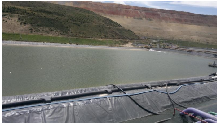
FOTO 03, Posa de operaciones – Solución cianurada.
