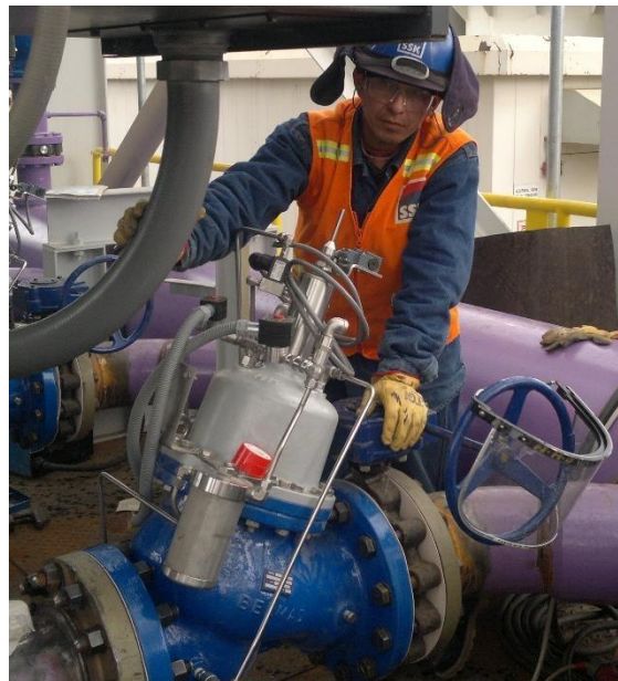
FOTO 04, montaje de válvula de retención y cierre progresivo.
