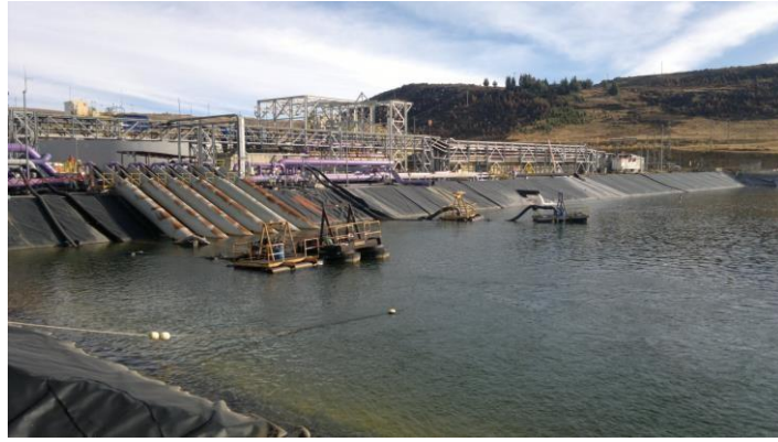
FOTO 02, Planta de tratamiento de Agua Columna de Carbón – Cajamarca.
