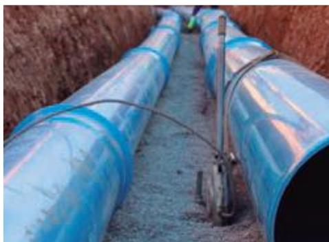
Figura 4. Tubería PVC-O
