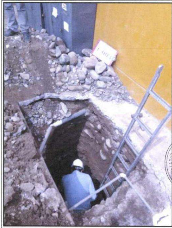
FOTO 9: Vista del perfil estratigráfico en la calicata C-003.
