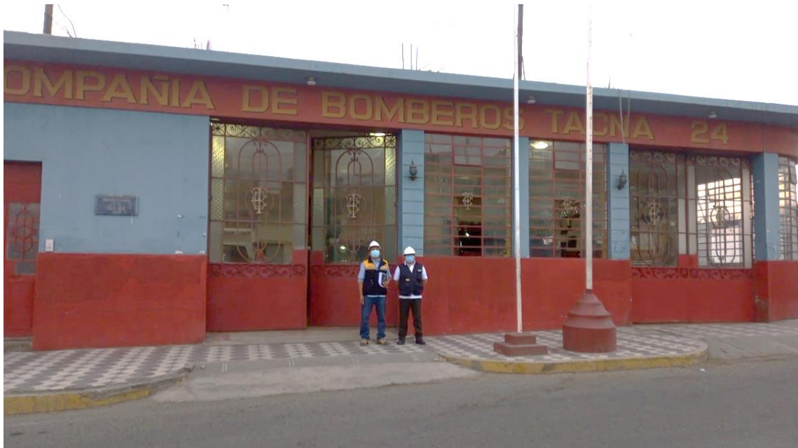
FIGURA 1: Vista de Ingreso y salida de compañía de bomberos Nro. 24 - Tacna
