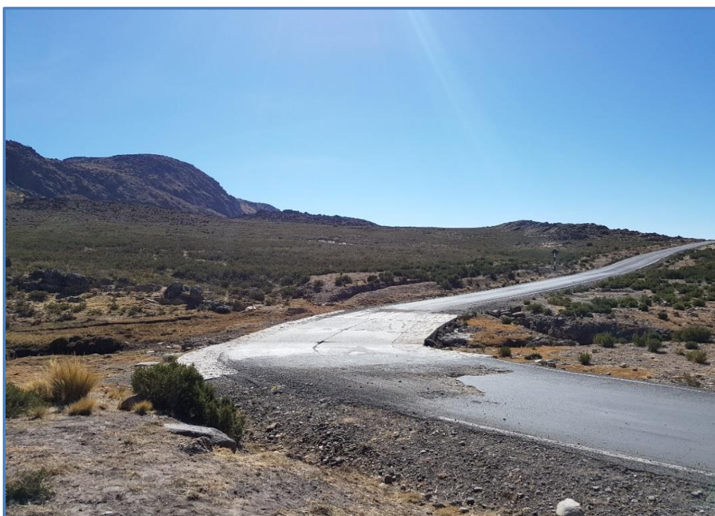
Figura 11. Ruta de acceso a Huanca sancos.
