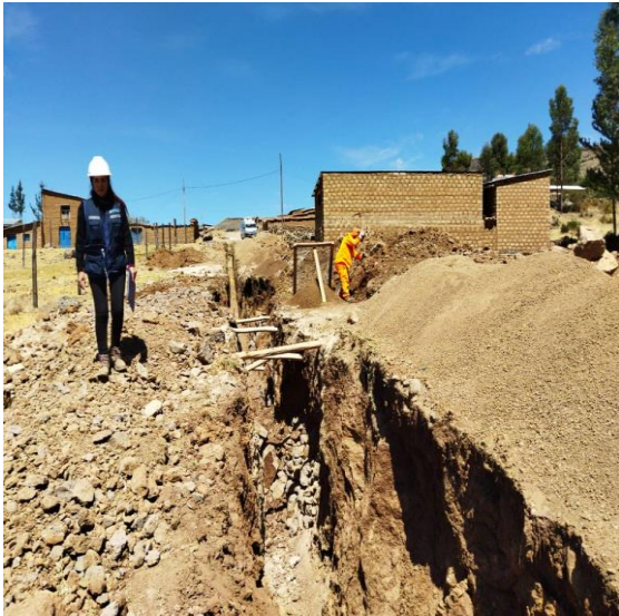
Foto 5. Excavaciones con entibados
