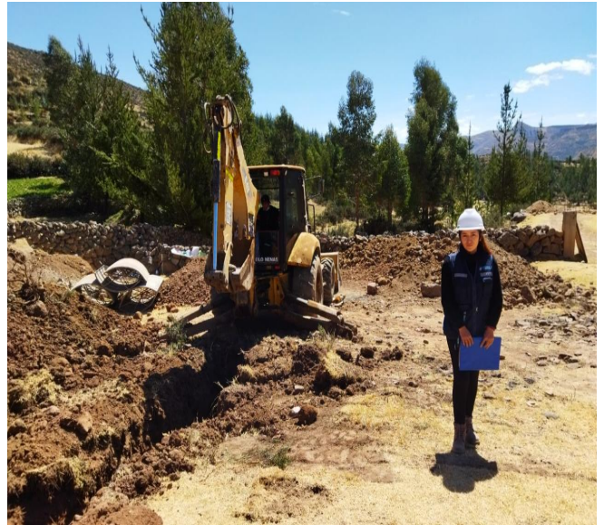
Foto 2. Excavacion de redes
