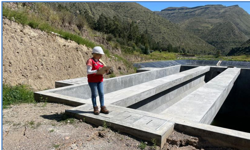
Figura 21. Tanque Imhoff construido
