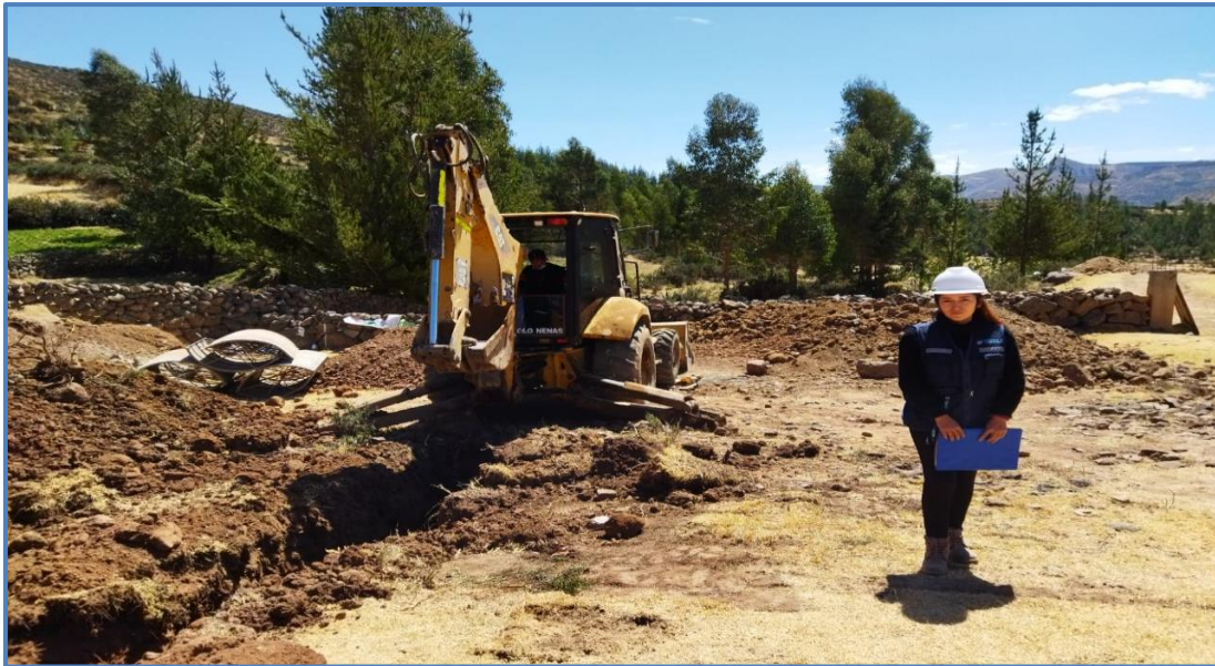
Figura 27. Tesista en la excavación para instalación de redes.
