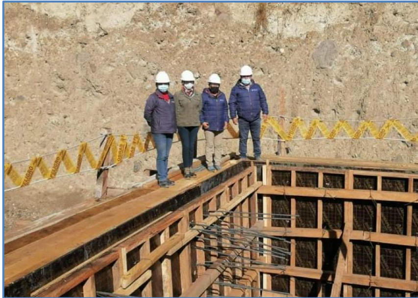
Figura 20. Encofrado de la construcción del Imhoff.
