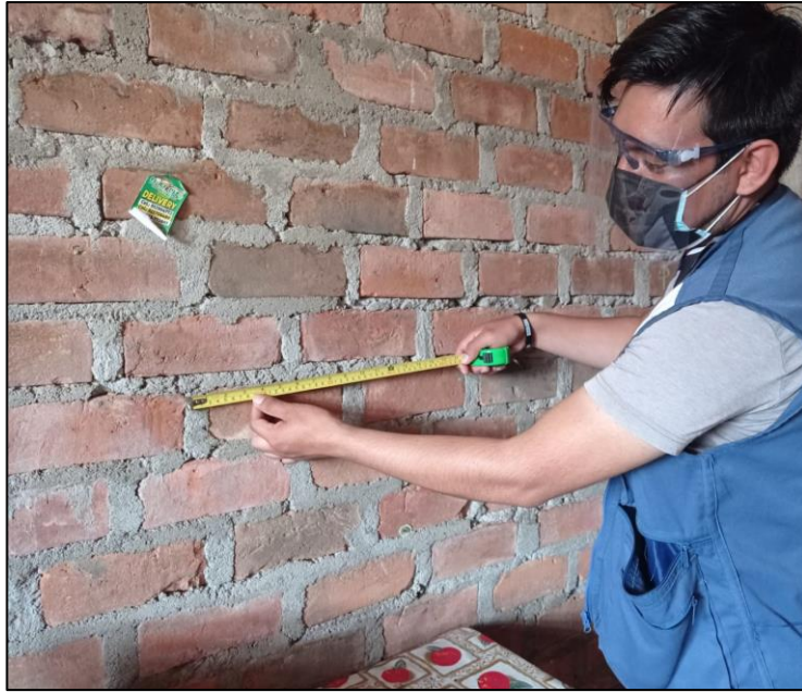
Foto 25 Medida de ancho de mortero.
