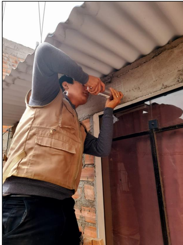
Foto 30. Realizando ensayo de esclerometría en viga de vivienda 01.
