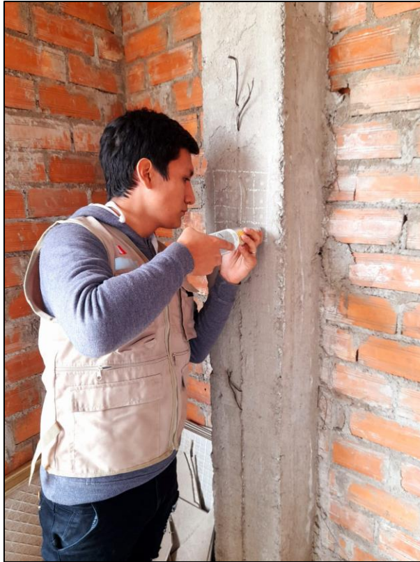
Foto 29. Realizando ensayo de esclerometría en columna de vivienda 01.
