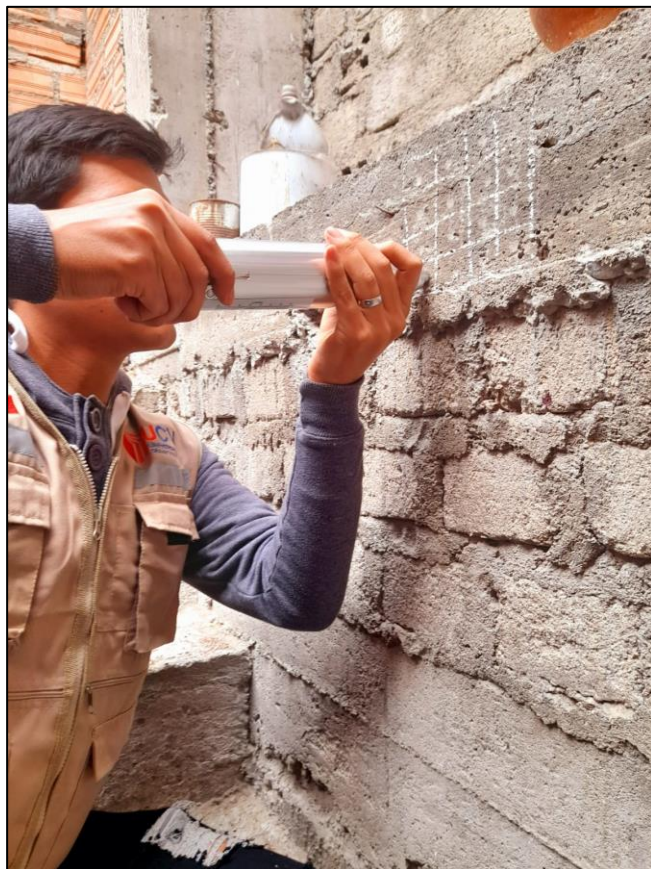
Foto 32. Realizando ensayo de esclerometría en viga de vivienda 02.
