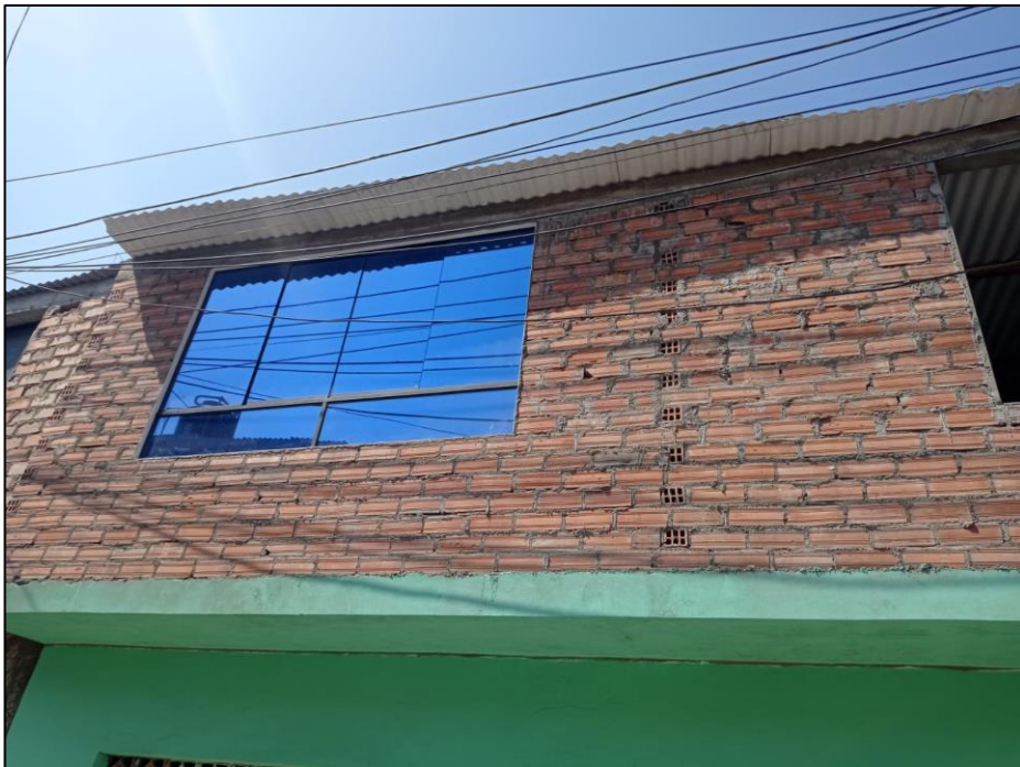
Foto 24. Uso de ladrillo pandereta.
