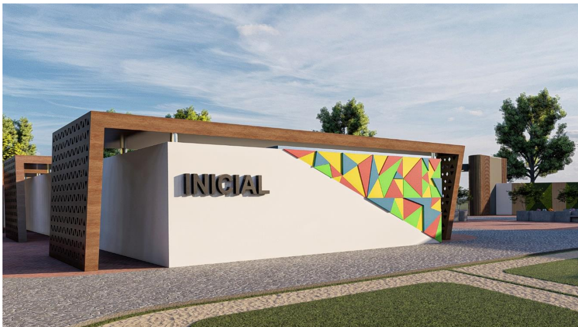
Figura 53. Vista exterior del pabellón del nivel Inicial
