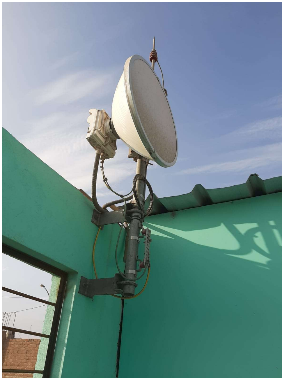
Foto 3: Antena de microondas con acceso a Internet de 20 Mbps
