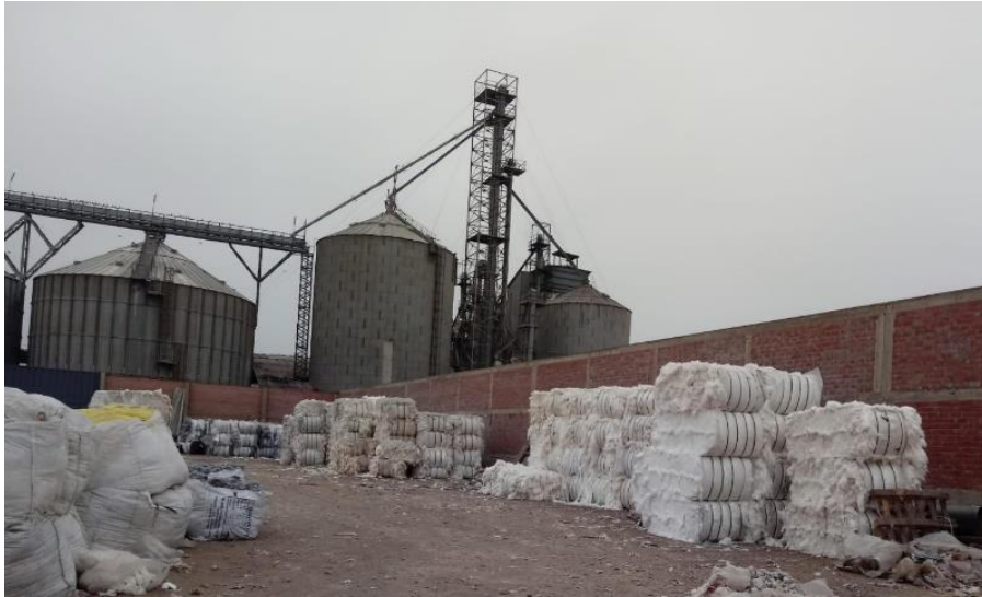
Figura 15. Almacén antes de la implementación de las 5s
