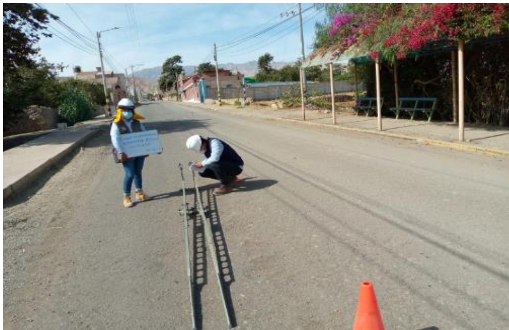
Figura 37. Ensayo de Viga Benkelman, Elaboración Propia.
