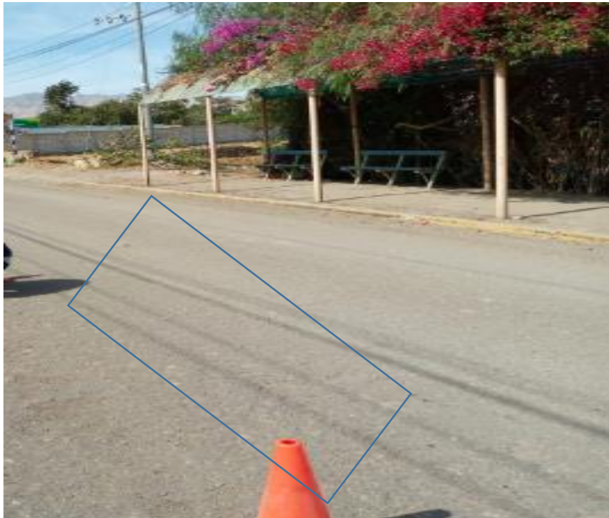
Figura 23. Falla n 5, Elaboración Propia.
