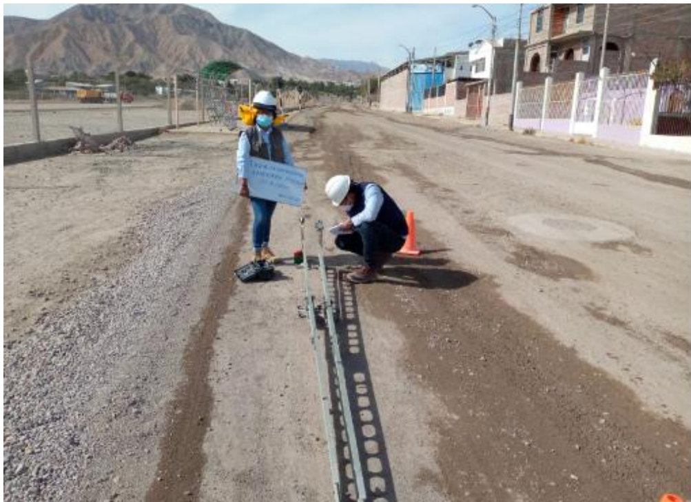
Figura 35. Ensayo de Viga Benkelman, Elaboración Propia.
