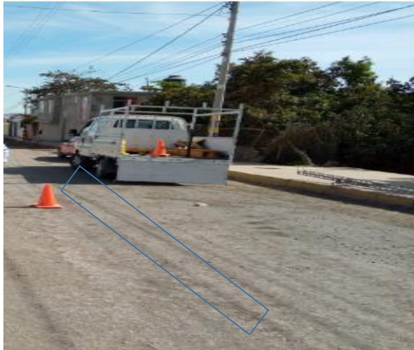
Figura 25. Falla n 7, Elaboración Propia.
