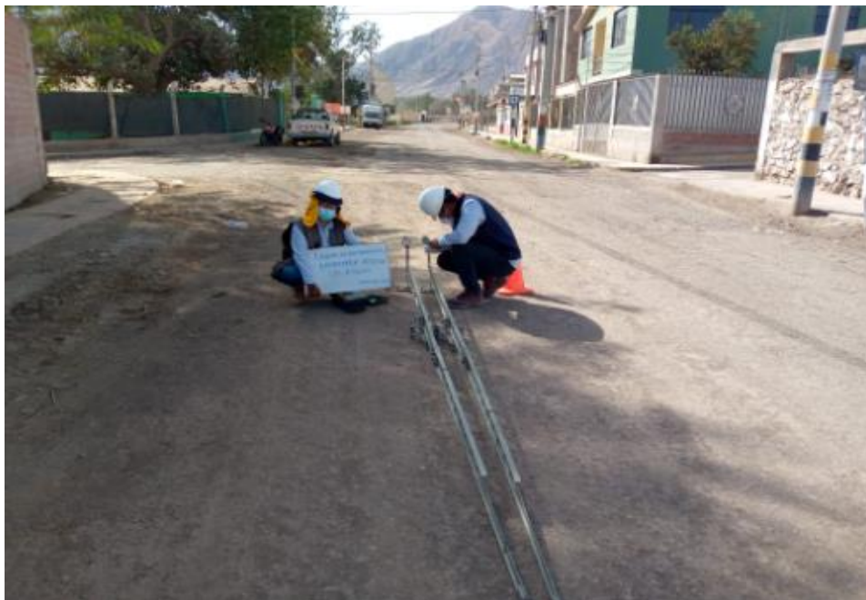
Figura 33. Ensayo de Viga Benkelman, Elaboración Propia.
