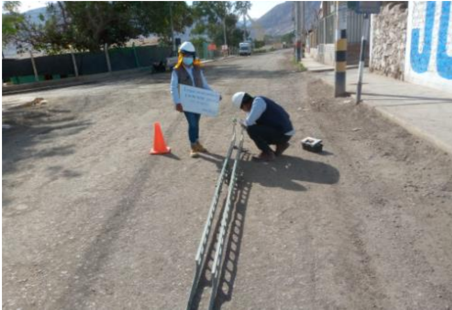
Figura 32. Ensayo de Viga Benkelman, Elaboración Propia.
