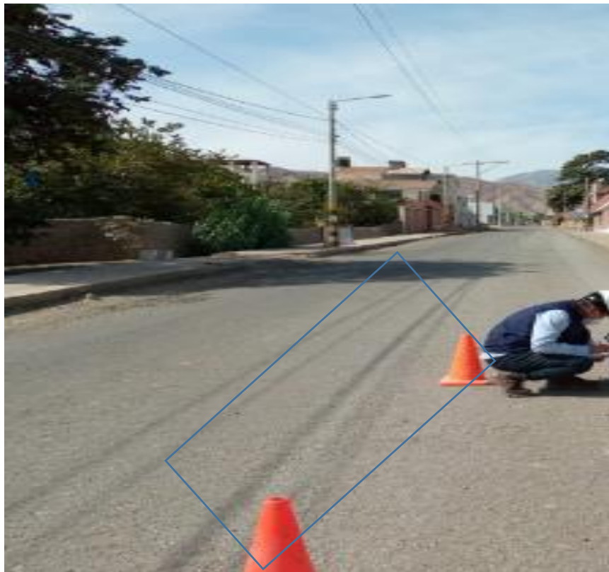
Figura 22. Falla n 4, Elaboración Propia.
