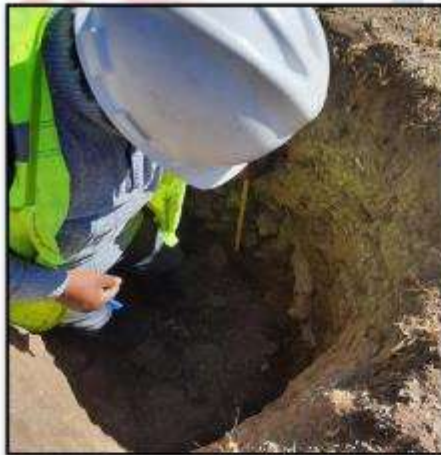
Medición del perfil estratigráfico de la calicata
