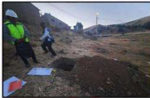
Observación y tome de dimensiones de la calicata.
