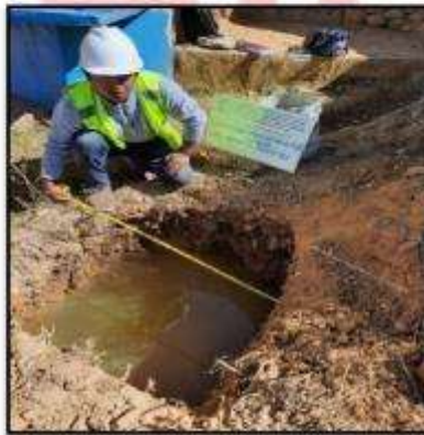
Figura 32 Registro del Nivel Freático Calicata N° 01
