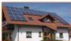
Alberca, sistema solar aguas
