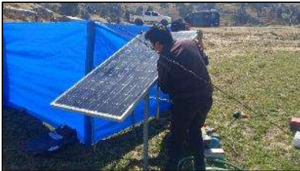
Instalación del panel solar con un pendiente de 15^\circ con la horizontal, dato referencial en la región de Puno por la inclinación del sol.
