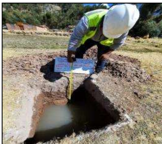
Figura 34 Registro del Nivel Freático Calicata Nro 2
