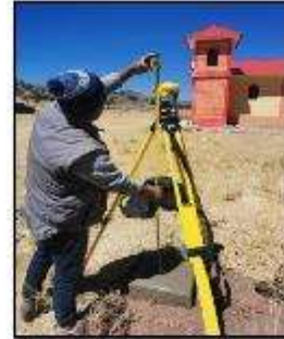
Imagen 01 e imagen 02. posicionamiento del GPS Diferencial en el punto de control PC-01 para enlace y ajuste de las coordenadas.
