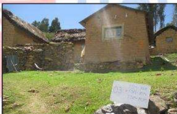
Figura 5 fotografías de las viviendas del sector
