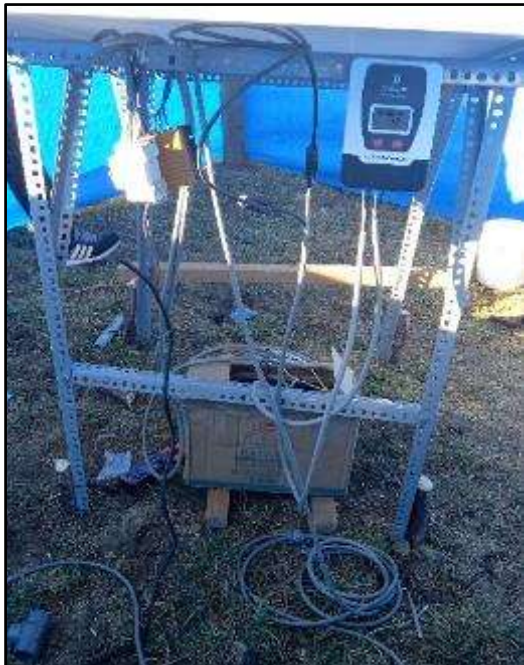
Instalación de los controlares: Controlador del generador de viento - eólico: Trifásico.
